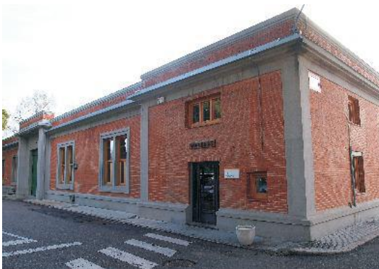
Edificio de Maderas
